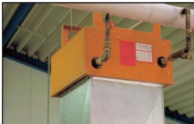
Sigillatura di impianto di ventilazione
