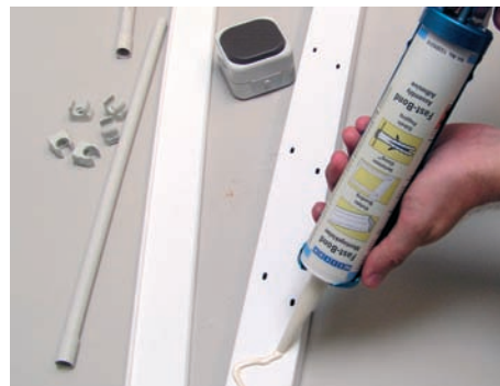
Fissaggio alla parete di una canaletta per cavi
