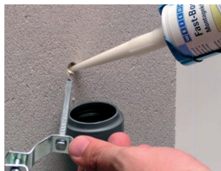
Fissaggio di un morsetto ad una superficie di Gasbeton
