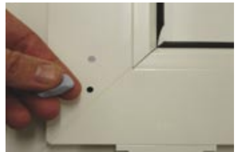
Rebouchage de dommages sur un cadre en PVC
