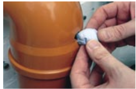
Réparation d'un tuyau de descente en PVC
