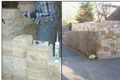
Flex 290 M - Collage de pierres en grès artificiel
