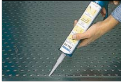
Flex 310 - Scellement de joints de dilatation dans une chambre froide
