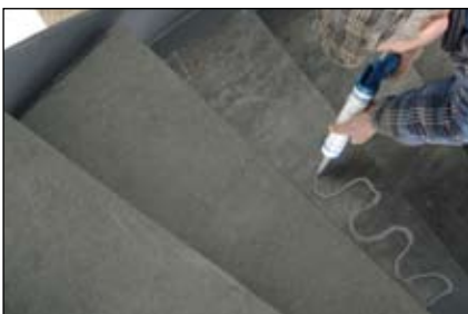
Flex 310 M - Collage de granit sur des tôles d'acier (escalier)
