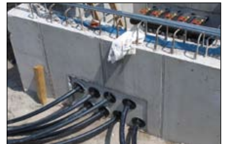
Flex 310 M - Isoler des conduites d'alimentation (passage de tuyaux)
