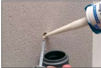
Fast-Bond - Collage d'une bride pour tuyaux dans du béton cellulaire
