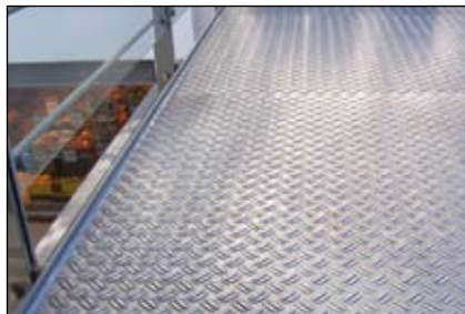
Flex 310 M - Collage de tôles d'aluminium gaufrées sur une chape
