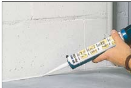
Flex 310 M - Étanchement d'un angle
