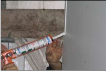
Flex 310 M - Collage de panneaux de polyester sur des tôles d'acier inoxydable
