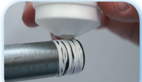
Déposer 2 à 3 gouttes d'agent lubrifiant (intégré dans le fond amovible) sur le fil d'étanchéité - biodégradable
