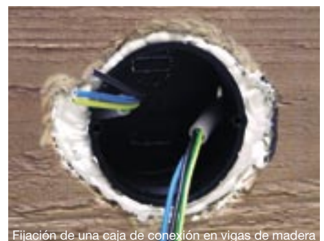
Fijación de una caja de conexión en vigas de madera
