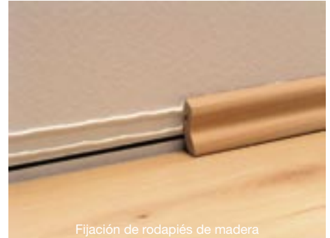
Fijación de rodapiés de madera
