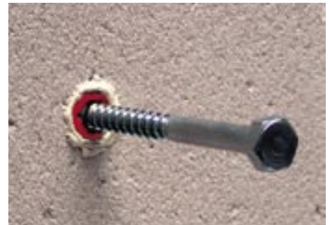
Fijación de tacos de plástico en bloques de hormigón
