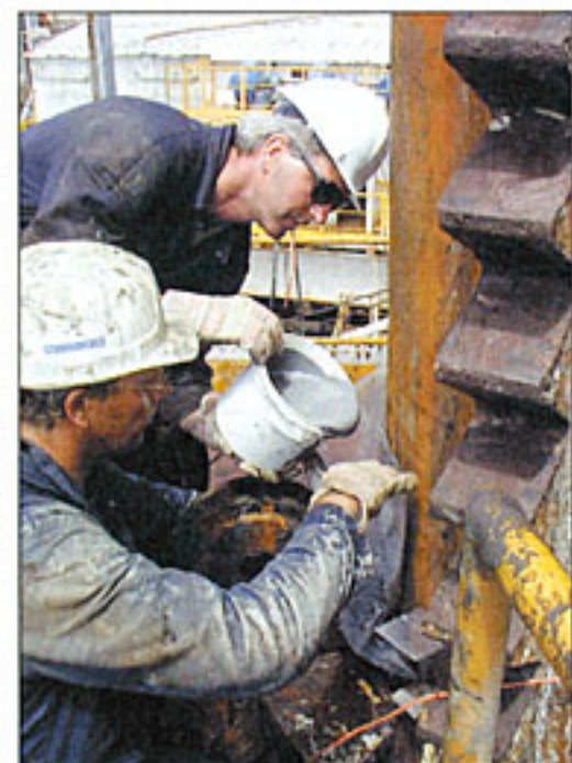
Im Prinzip ganz einfach: Die Mitarbeiter kippen den Drei-Komponenten-Kleber in die Polstertaschen. Zwei Tonnen des Spezialklebers verarbeitet das Weicon-Team vor der Westküste Afrikas.
